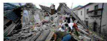
Terremoto magnitudo 6 nel centro Italia: disastro, vittime
