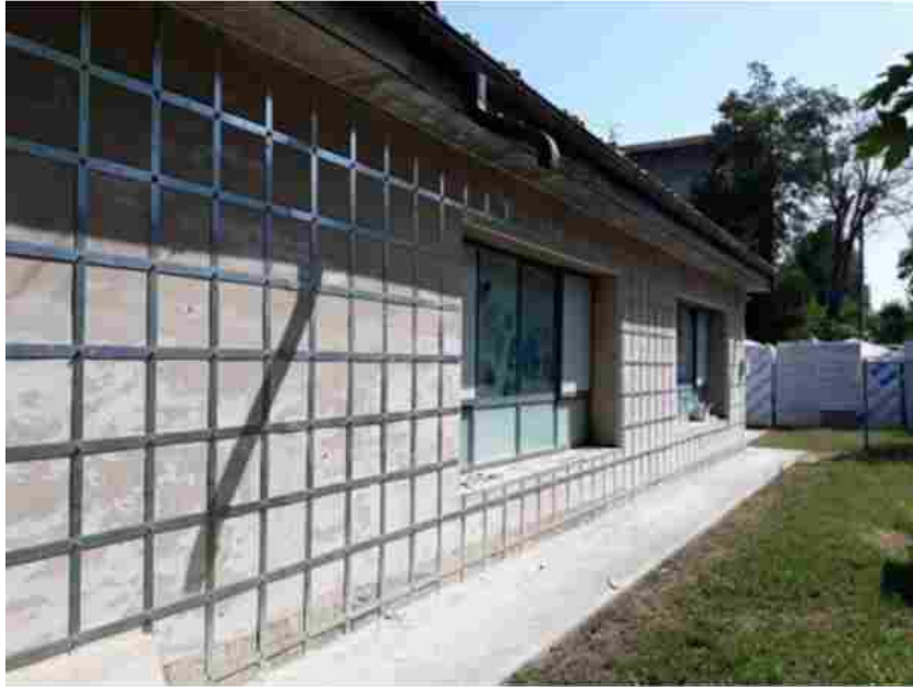
Scuola dell'infanzia oggetto dell'intervento (Credits: Progetto Sisma)
